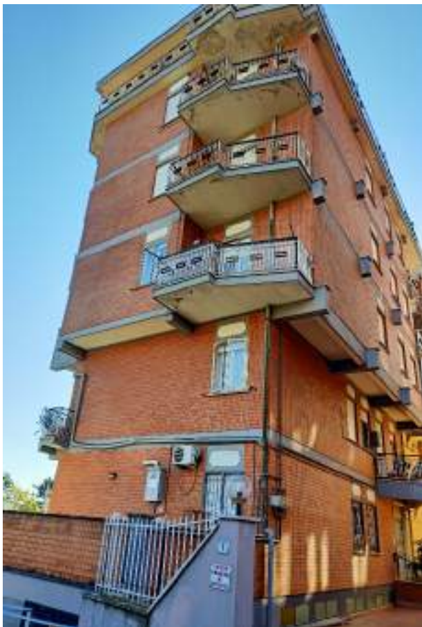
FOTOGRAFIA N° 3 Prospetto B Cortile d'ingresso
