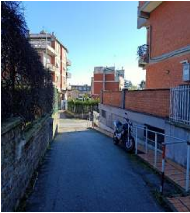
FOTOGRAFIA N° 1 Prospetto B Cortile d'ingresso
