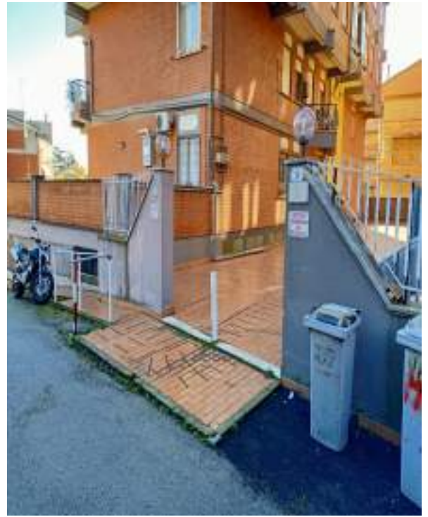
FOTOGRAFIA N° 2 Prospetto B Cortile d'ingresso
