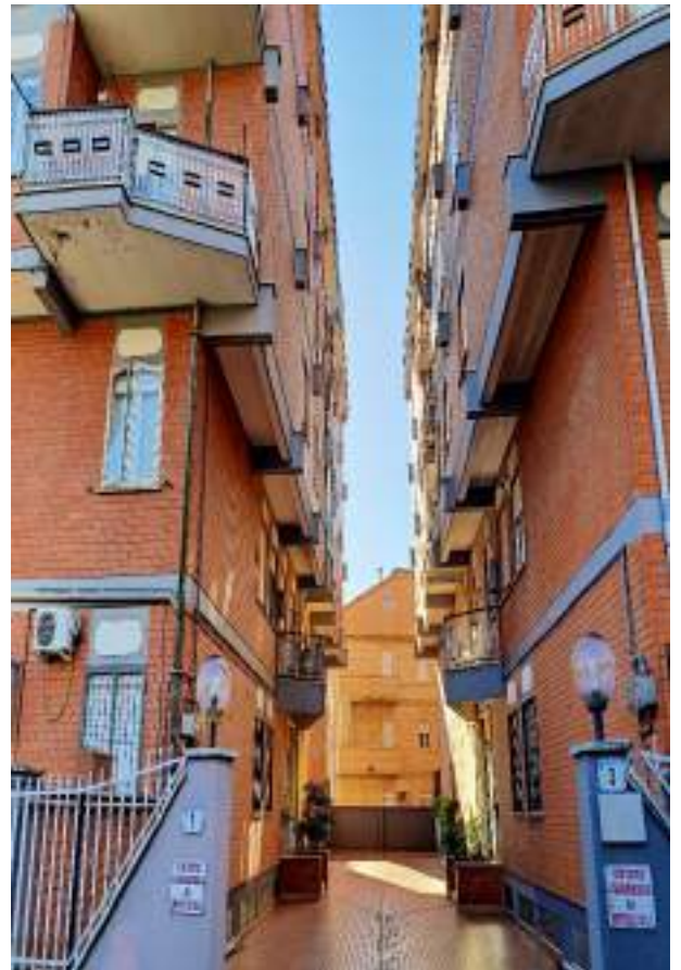
FOTOGRAFIA N° 4 Prospetto B Cortile d'ingresso
